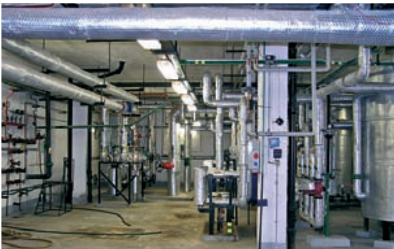
Během léta probíhaly opravy a rekonstrukce ve výměňkových stanicích, topných kanálech i kolektorech inženýrských sítí.
